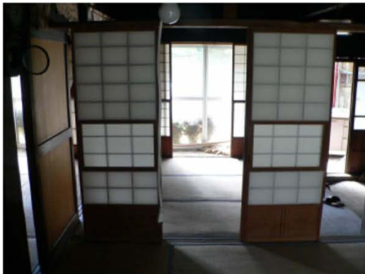
内部は良好に維持管理されており、畳を入れ替えて使用可能。
