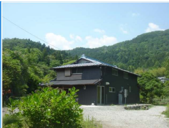
北側より敷地・建物全景
