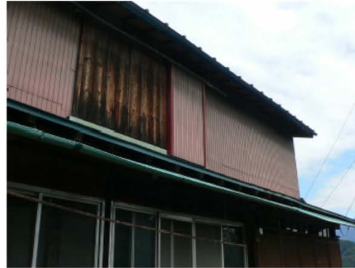
屋根は金属板葺き。外壁は土壁の上に金属板張。
