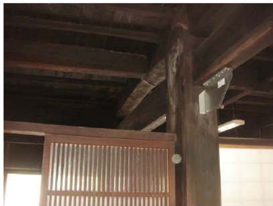
古い大黒柱や梁・垂木現し、既存の格子建具を生かした空間
